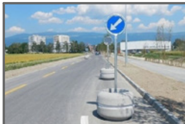
Route de contournement secteur Sud
